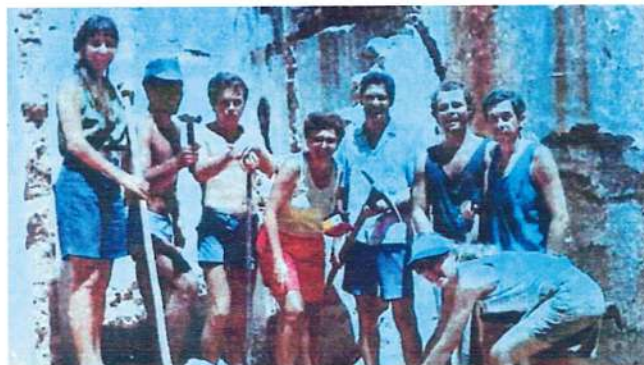
Voluntários construindo a sede na década de 90
